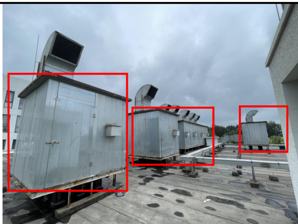
废气治理风机隔声罩
