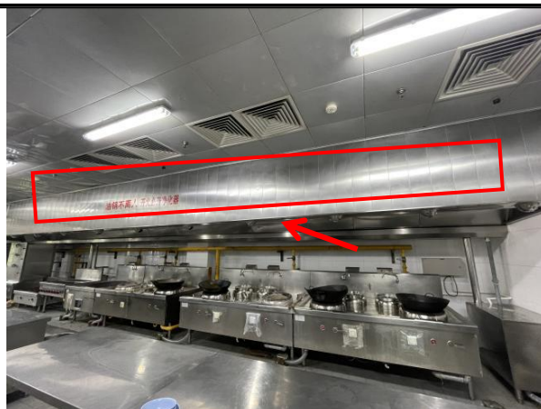
二层食堂集气罩+油烟净化器 (油烟净化器置于集气罩内部)
