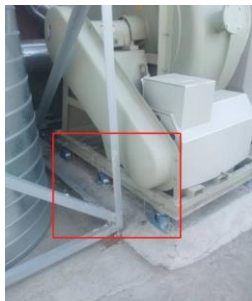
废气治理设施减震垫
