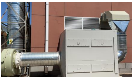
一层制剂实验室废气治理设施
