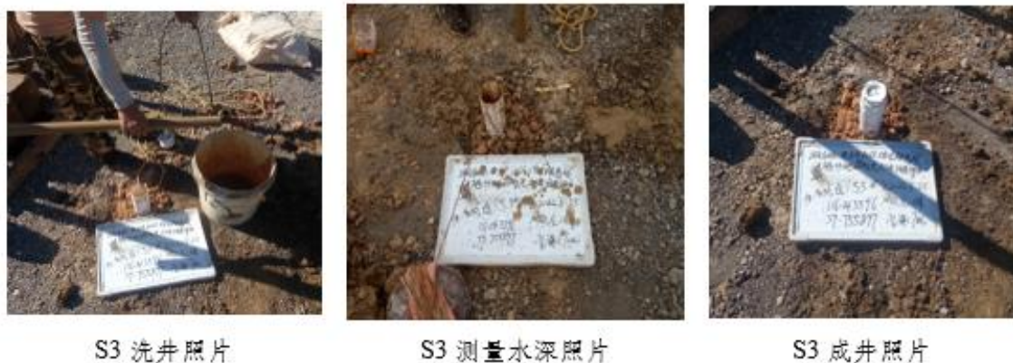
图5-3 地下水建井现场照片
