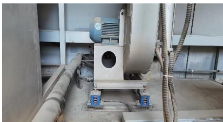
废气治理设施基础减振
